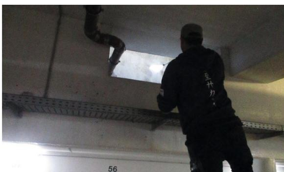
Mit fahrbarem Gerüst werden schnell und sauber alle Wandflächen abgestrahlt,
